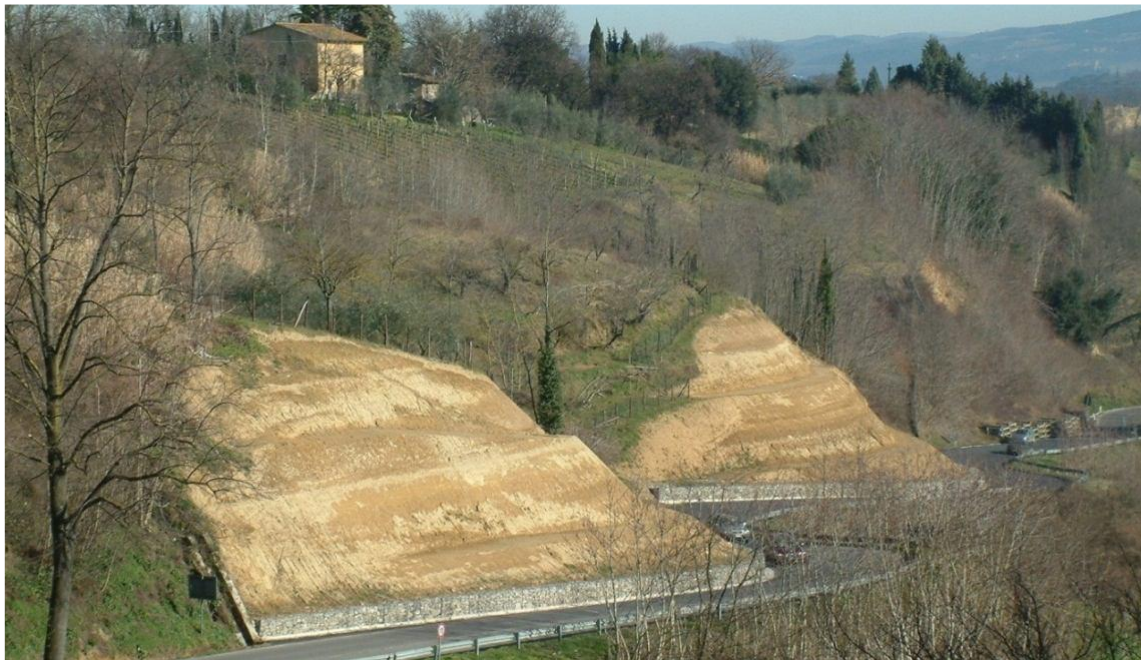
Stabilizzazione di un versante tramite intervento di gradonatura
