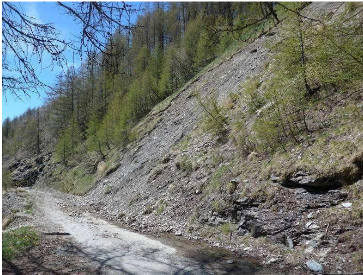
Foto sopralluogo Sogesid marzo 2024
