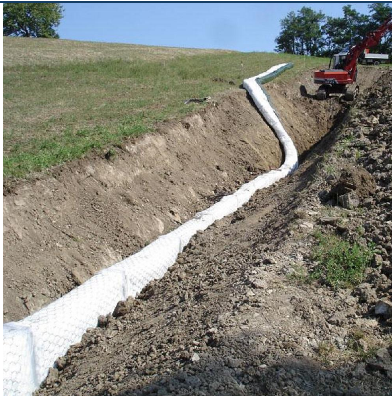
Trincea drenante con elementi prefabbricati
