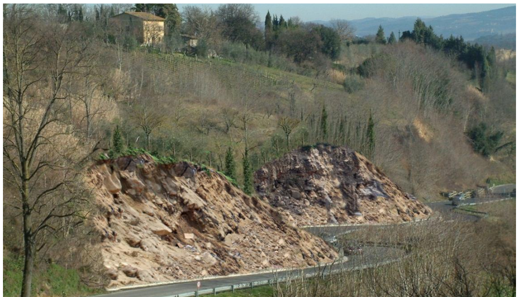
Fonte: Rielaborazione foto da Linee guida per la sistemazione e manutenzione dei versanti" AUTORITA' DI BACINO REGIONALE DELLA SARDEGNA
