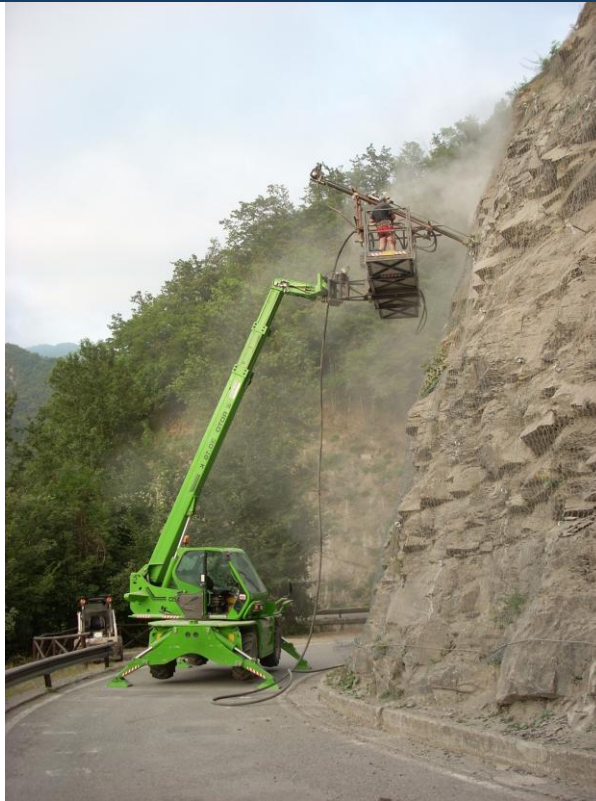
Rimozione di lastra instabile
