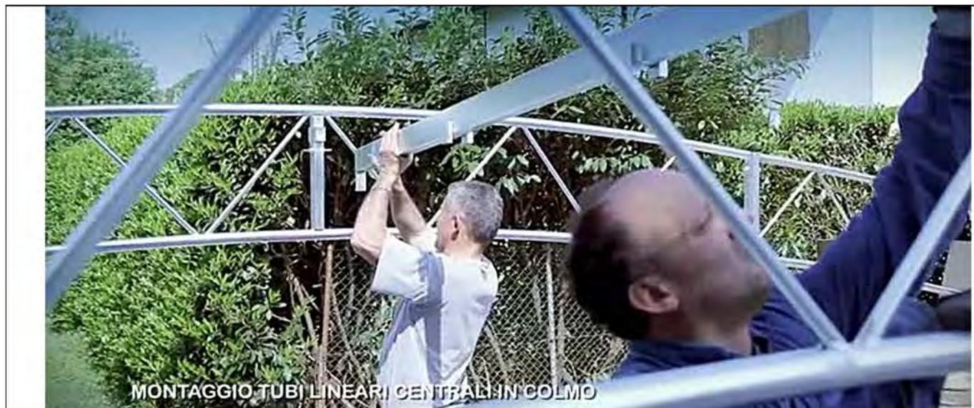
18. Procedere con il montaggio delle diagonali per mettere la struttura in perfetto squadro;
