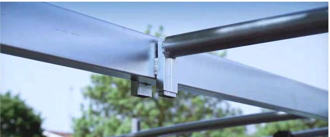
14. Per quanto riguarda le estremità a sbalzo della struttura, per poter montare le arcate, bisogna unire i Supporti (C) alle relative Capriate Lineari (B) con le apposite viti M16x80 come in figura;
