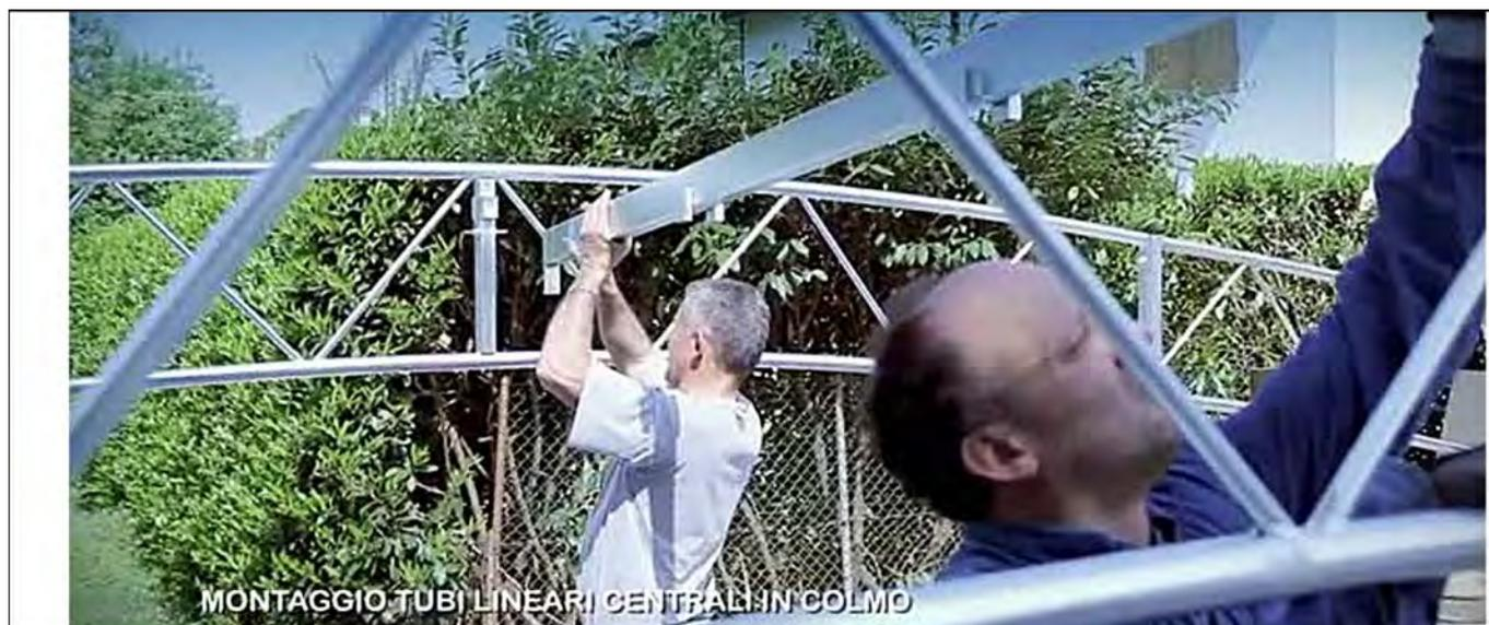
10. Procedere con il montaggio delle diagonali (elemento 10) per mettere la struttura in perfetto squadro;
