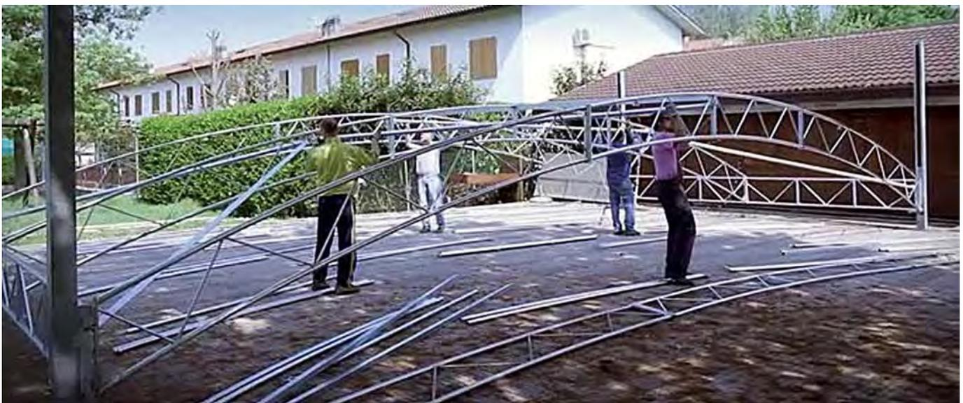
11. Collegare fra loro le arcate con i Tubi di Collegamento Capriate (elemento 6) impiegando le apposite viti M10x30;
