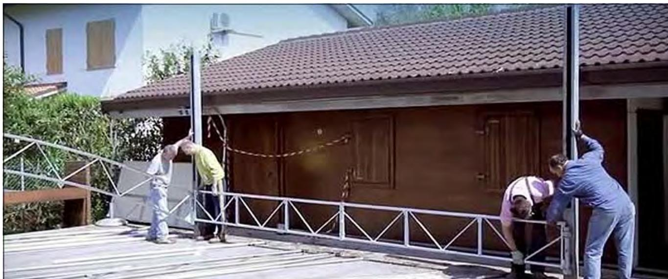
7. Inserire poi le viti M16x35 per unire saldamente le arcate all'attacco sali-scendi (mazza) e completare con le viti M16x140 per unire fra loro le capriate lineari sempre alla mazza;
